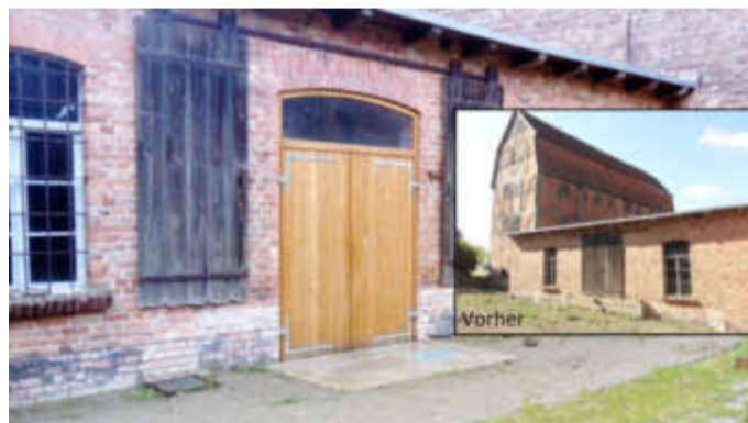
Lübecker Speicher Demmin - schwellenfreier Zugang
