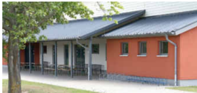
FSV Machin - Sanierung Vereinsheim
