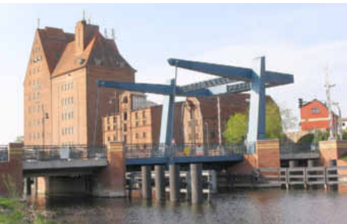
Demminer Stadthafen mit saniertem Lübecker Speicher
