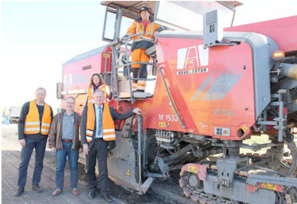
Kurze Pause für den Mann auf der Fräse, um das Erinnerungsfoto mit den drei Bauherren zu machen (v.l.): Uwe Schmidt, Wasserzweckverband Malchin Stavenhagen, Bürgermeister Udo Kahlert und Landrat Heiko Kärger. Hinter ihm die Bauleiterin Marlies Kolchynski.
