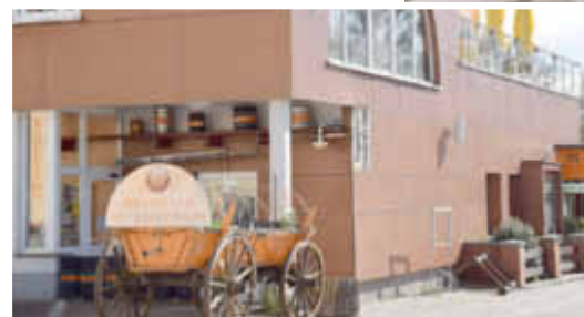
Das Brauhaus mit Blick auf die Hochterrasse und die Fenster der „Gläsernen Brauerei“
