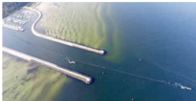
Lehrrohre werden offshore zum Windpark transportiert
