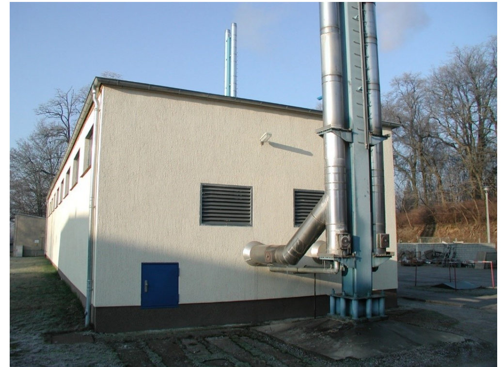
Das Heizhaus am Biestorfer Weg
