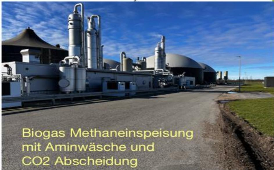
Biogas Methaneinspeisung mit Aminwäsche und CO2 Abscheidung
