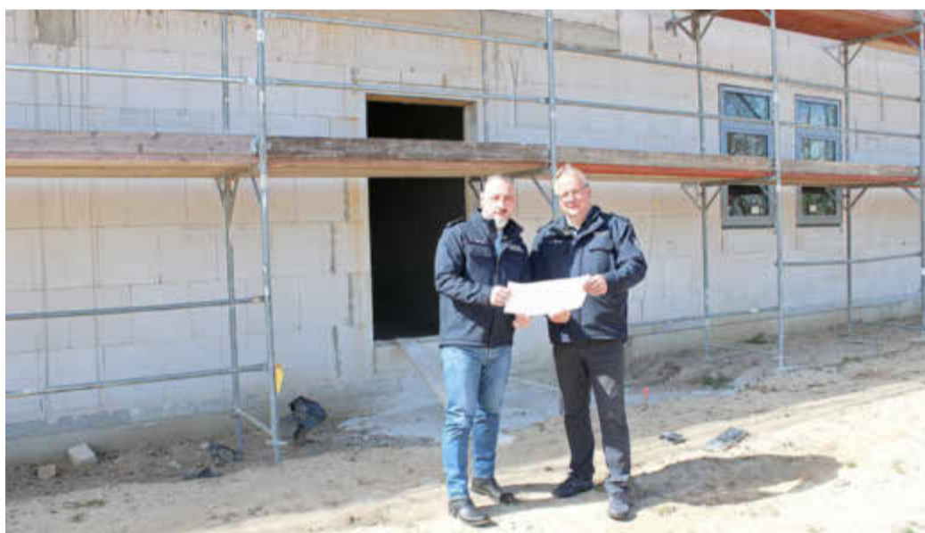
Auf dem Gelände der Feuerwehrtechnischen Zentrale (FTZ) in Neuendorf hatten sich der Stellvertretende Landrat und Dezernent Thomas Müller (r.) und Ordnungsamtsleiter Peter Handsche einen Überblick über den Baufortschritt verschafft. Foto: Archiv LK/MSE
