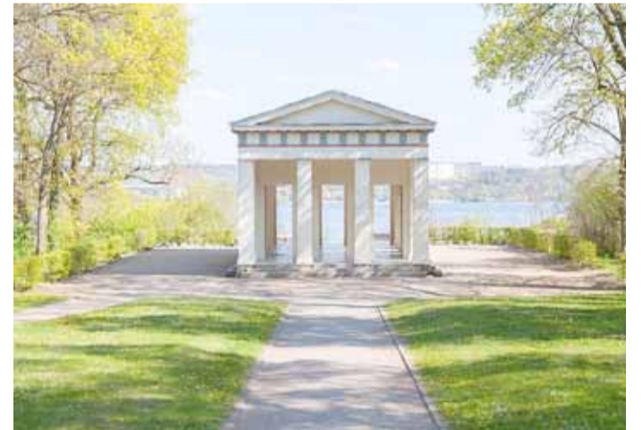
Belvedere am Tollensesee
